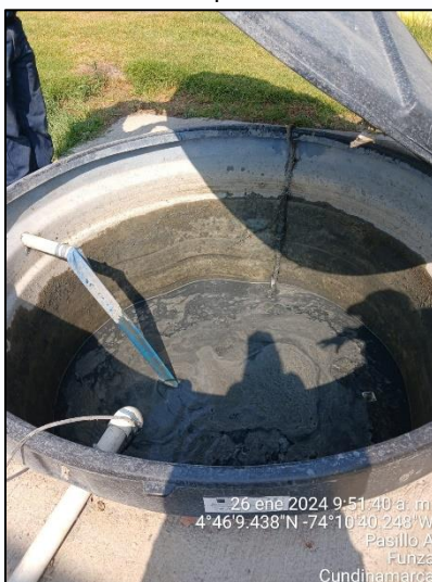
Ilustración 11. Espesadores de lodo
