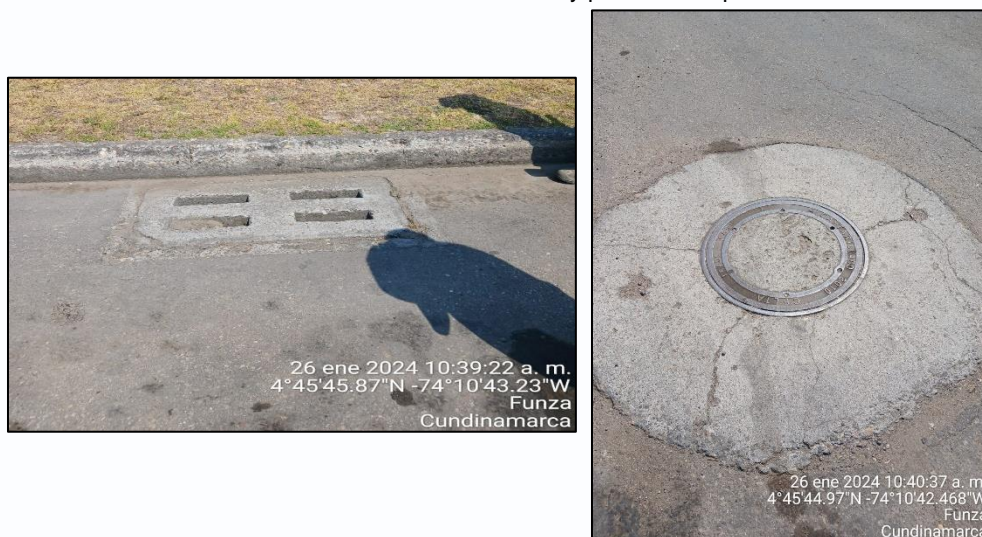
Ilustración 22. Sumideros y pozos de inspección
