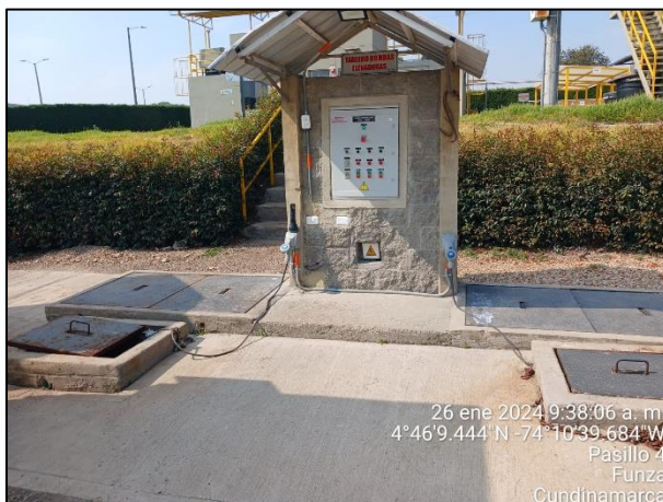
Ilustración 4. Tanque de almacenamiento y tablero de bombas
