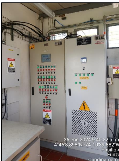
Ilustración 14. Tablero de control sistema de automatización
