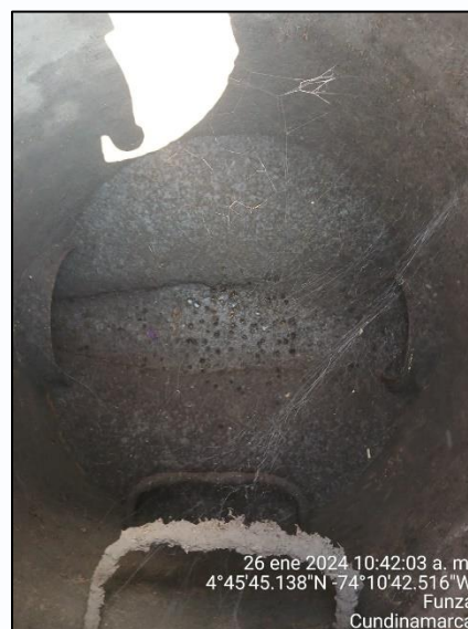
Ilustración 23. Pozos de alcantarillado pluvial secos
