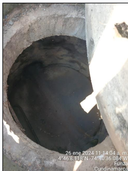
Ilustración 23. Pozos de alcantarillado pluvial secos
