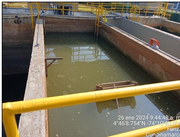
Ilustración 6. Sedimentación
