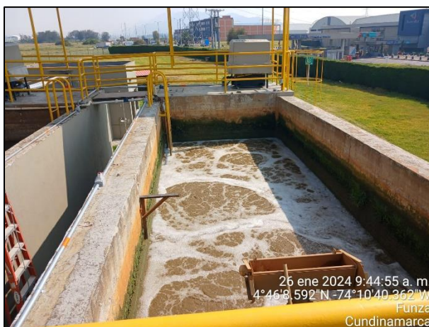
Ilustración 7. Reactores lodos activados
