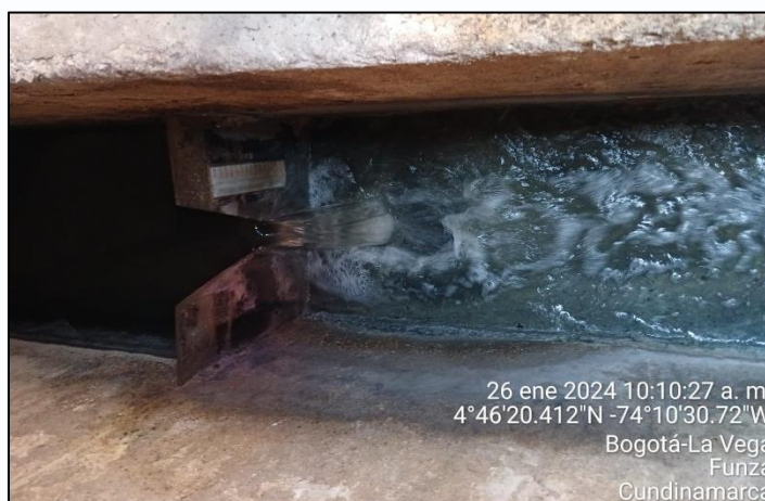
Ilustración 15. Canaleta de medición de caudal de ARnD
