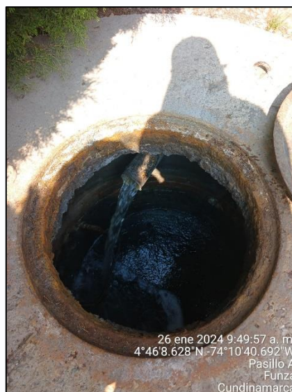
Ilustración 10. Pozo descarga PTAR
