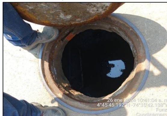
Ilustración 24. Pozos de alcantarillado pluvial con agua
