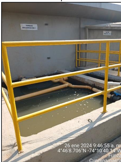
Ilustración 8. Tanque de decantación
