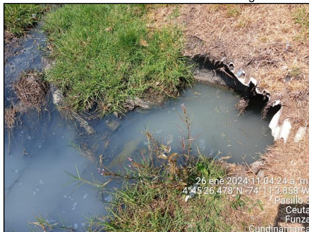
Ilustración 25. Descarga alcantarillado pluvial reservorio 4
